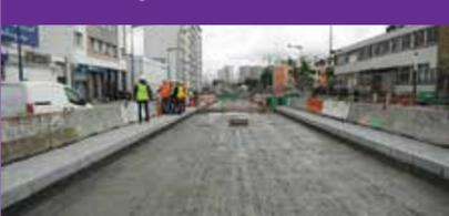
4 Le positionnement des traverses et la pose des rails
