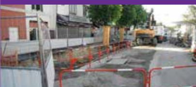
2 La mise en place de multitubulaires pour les câbles (1).
