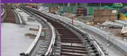
5 Le réglage des rails et la soudure
