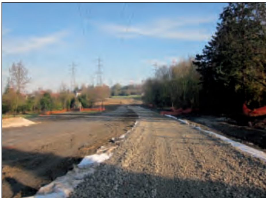
Apport de cailloux du côté de Pierrefitte. (Photo : © AEV/L. Baretaud).
