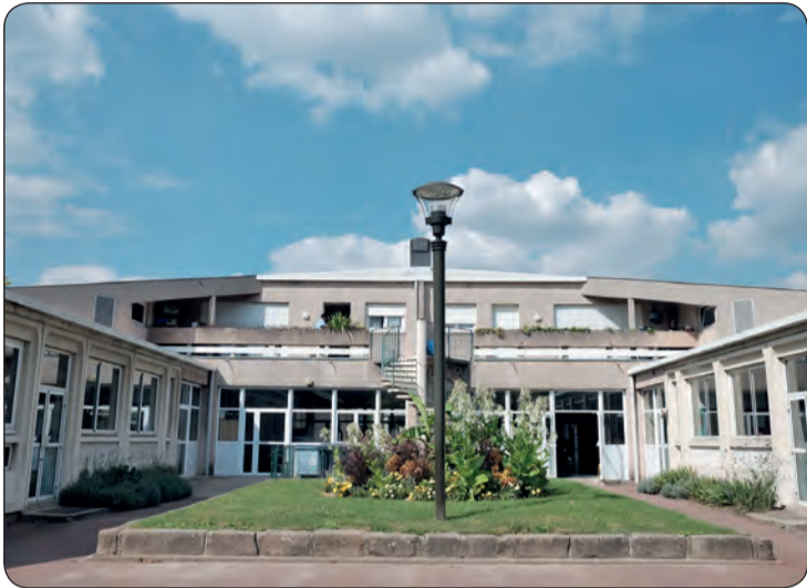
L'école Jacqueline-Quatremaire va connaître une importante rénovation qui va débuter l'été prochain pour durer toute l'année scolaire 2019/2020. (© EQ)
